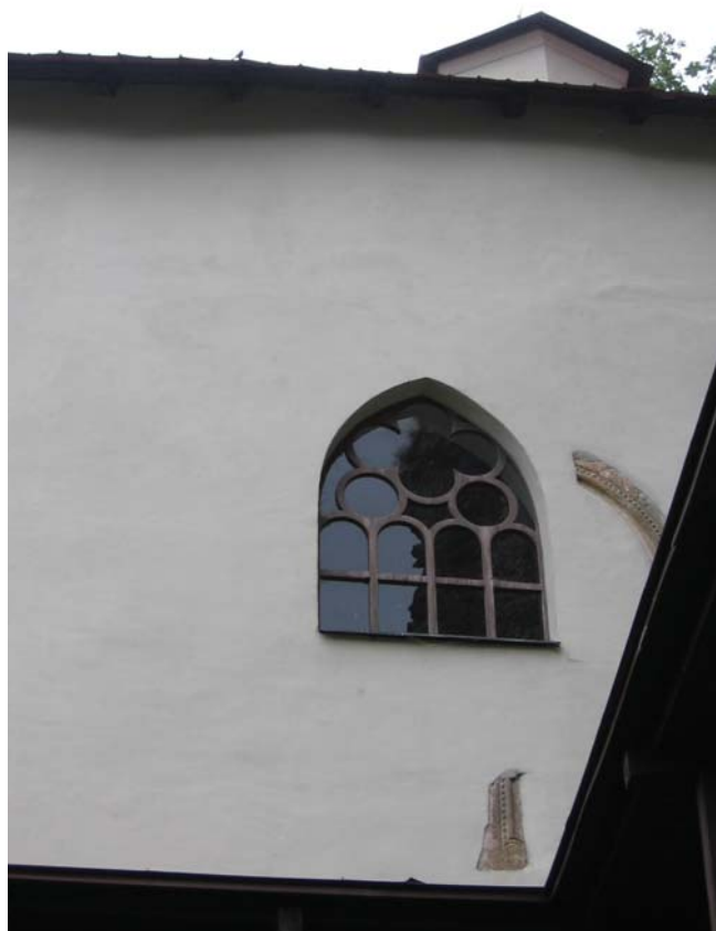
Obr. 7 – SZ fasáda objektu kaplniek so sekundárne osadenými kamennými architektonickými článkami okna a portálu – súčasná prezentácia, 2010, archív autorky
