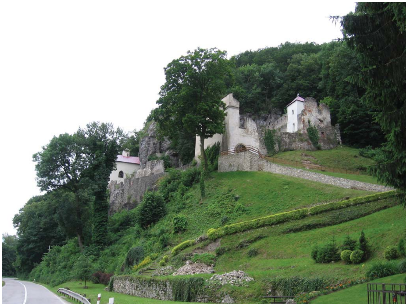
Obr. 1 – Pohľad na areál benediktínskeho kláštora na Veľkej Skalke zo severu s prístupovým chodníkom, 2010, archív autorky
