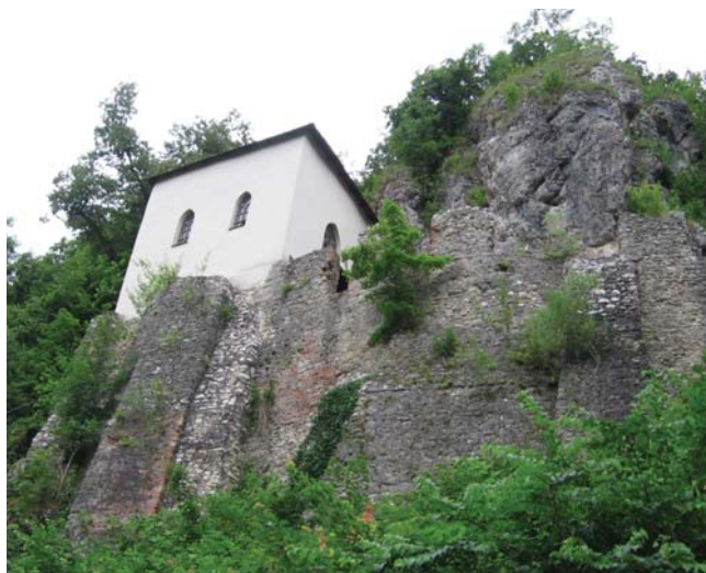
Obr. 6- Pohľad na trojpodlažný objekt kaplniek a SV oporný múr kláštorného areálu Veľkej Skalke, 2010, archív autorky
