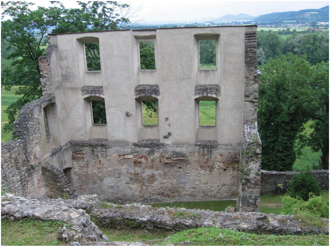
Obr. 8 - Rekonštrukcia vonkajšieho, t.j. severovýchodného múru bývalej vstupnej trojpodlažnej budovy, 2010, archív autorky
